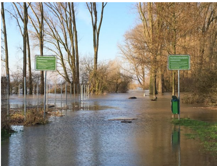
Der Hundesauslaufplatz in Wesel steht komplett unter Wasser.
